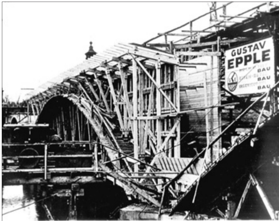
Eines von vielen Großprojekten der Firma Gustav Epple in den 100 Jahren des Bestehens: Bau der König-Karls-Brücke in Stuttgart-Bad Cannstatt in den Jahren 1945 bis 1948
